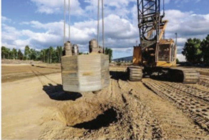
Şekil 7. Dinamik Kompaksiyon Uygulamasında Kullanılan Tokmak
