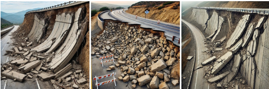
Şekil 5. Deprem etkisine maruz kalmış beton ve taş duvar istinat hasarı “Yazar tarafından hazırlanmıştır.”
