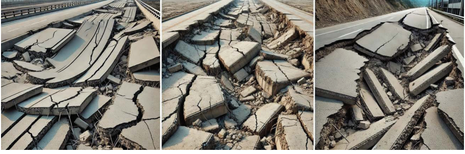
Şekil 3. Deprem sonrası rijit yol üst yapısı hasar türleri “Yazar tarafından hazırlanmıştır.”
