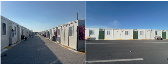
Şekil 48. Konteynır kentte yapılar arası mesafe
