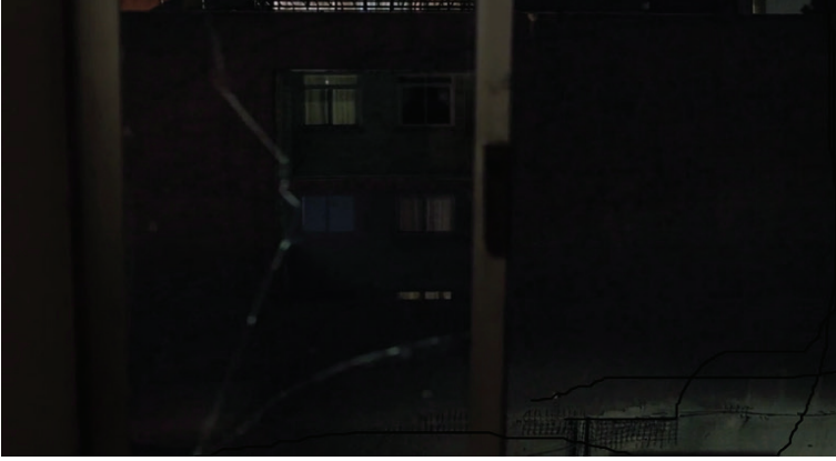
Görsel 52. Pencere Camlarının Çatlaması
