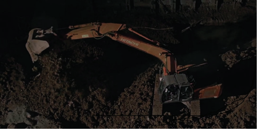
Görsel 51. Apartmanın Yanında Çalışma Yapan İş Makinesi
