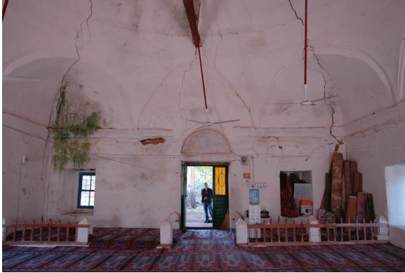
Resim 3. Güney cephesi iç mekanı
