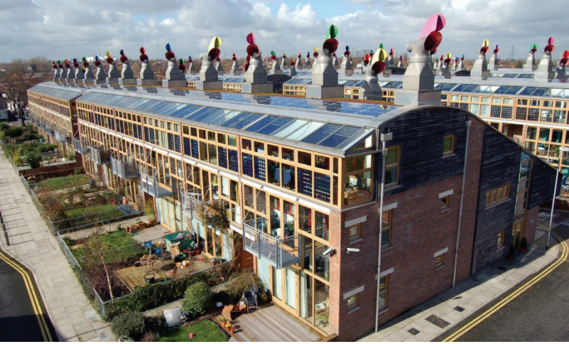
Şekil 14. Bedzed geliştirme, Londra (enlem 51.5°K), doğal havalandırma için rüzgar kulelerinin kullanımı (Haggard ve ark., 2016)
